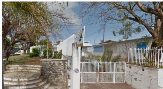
Bâtiment de l'ex-PMI – futur Carrefour de l'Entrepreneuriat
